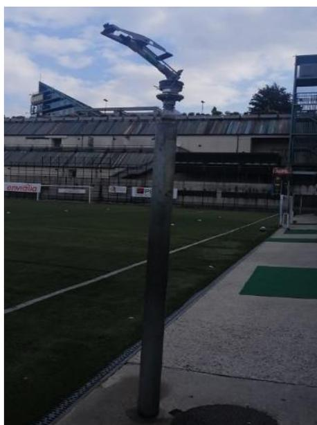
Las presiones y caudales de diseño tendrán que ser suficientes para poder cubrir la totalidad de la superficie del campo de hockey (actualmente solo hay 6 cañones con una altura de salida de impulsión demasiado baja, quedando siempre zonas centrales del campo sin regar) con una altura de impulsión de salida respecto al suelo de 2 metros aproximadamente como mínimo, fácilmente protegible, como muestra la foto anexa de otra infraestructura de la ciudad de Ourense (campo futbol Salesianos).
